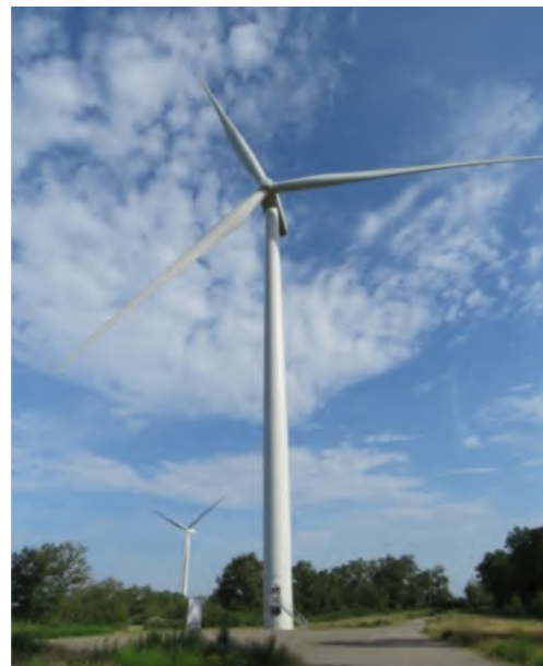
Parc éolien Les Patoures, commune de Lussac-les-Eglises
